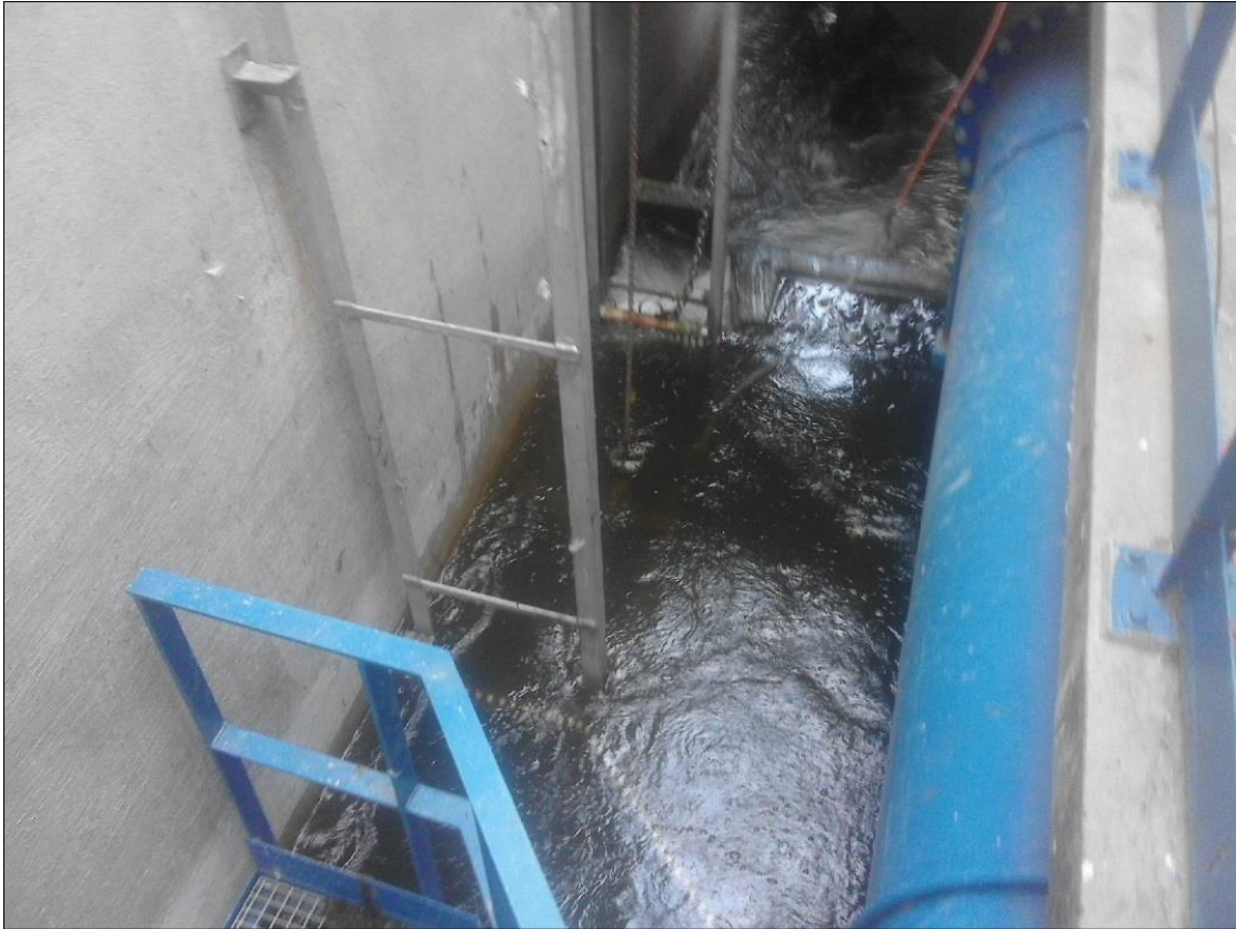
Fot. nr 1. Przepiętrzenie wody w komorze skanera spowodowane nadmiarem napływającej roślinności (jesień 2018).
