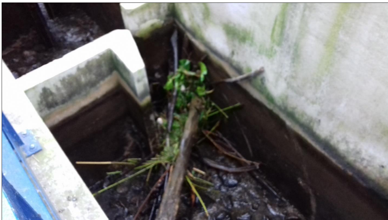
Fot 4,5. Nieczystości zgromadzone na koszu w komorze nr 60 i 54, przyniesione z wodą wezbraniową (maj i czerwiec 2019).
